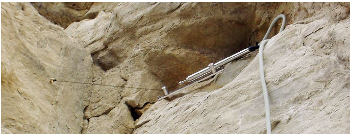
Déformètre électrique installé sur une falaise rocheuse
